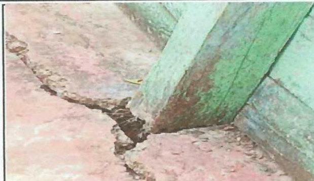
Foto 2: EL ESTABLECIMIENTO CUENTA CON ALGUNAS COLUMNAS DE CONCRETO.
