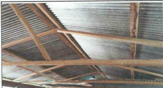
Foto1: SE CAMBIARÁ VIGAS DE MADERA POR COSTANERAS.
